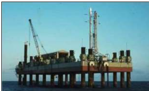
Fig. 3 – Piattaforma San Marco
